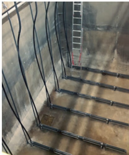
Ukotvovanie prevzdušňovacích elementov
