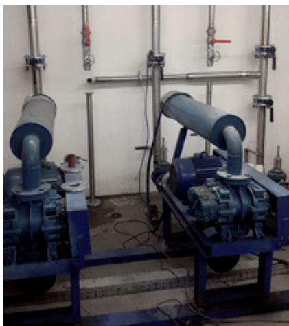
Výmena ventilov k dúchadlám
