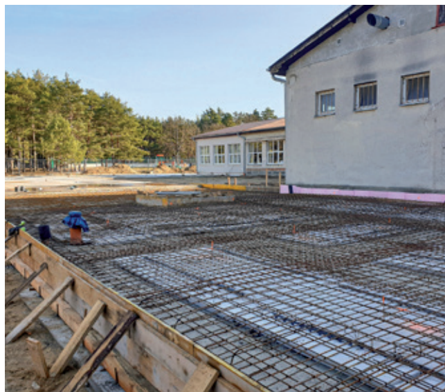
Výstuž dosky pred vstupom do kuchyne
