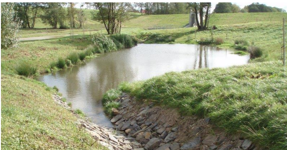
Obrázok 26 Ukážka ochrannej nádrže ( https://www.nase-voda.cz/litultovice-chrani-proti-vode-nove-vybudovana-suchanadrz-cholticky/ )
