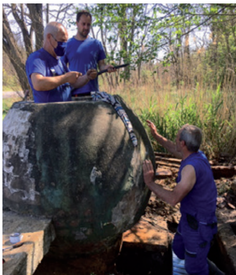
Prepoj prívodu vody, čistenie vnútra „gule“
