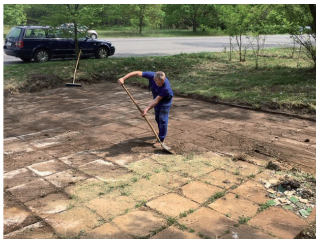
Čistenie dlažby od niekoľkoročného nánosy zeminy a trsov trávy
